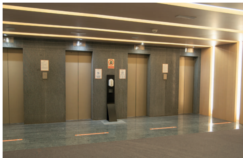
Ascensores que dan acceso al Auditorio MGS
