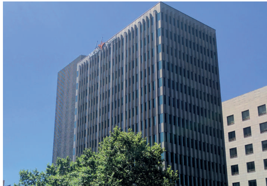
Edificio MGS, en la confluencia entre Av. Diagonal y calle Entença
